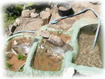
Hier wird gerade ein Wasserfall selber gebaut. Sie finden übrigens auch eine [Anleitung zum Bau von Wasserfällen](#) im jeweiligen Kapitel. Dieser hier ist betoniert worden. Dadurch kann man den kompletten Wasserfall wie mit Knetmasse modellieren. Somit kann man die grösstmögliche Flexibilität ausnutzen, die man dazu braucht. Die Oberfläche des Betons ist mit Abdichtschlämme und Schwimmbadfarbe versiegelt worden. In den Staustufen des Wasserfalls kann man auch Teichpflanzen einbauen.
