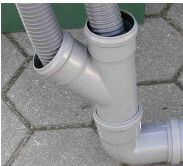
Auf diesem Foto ist nochmals das Y-Stück des grauen KG Rohrs mit 75 mm für den Rücklauf zum Teich zu sehen. Dadurch können Sie die beiden *Auslaufschläuche der letzten Filterkammer des Teichfilters optimal bündeln*. Sichern Sie die beiden Spiralschläuche dann mit Kabelbindern. Im jeweiligen Kapitel dazu sehen Sie auch ein Foto mit der Kabelbindermontage.
