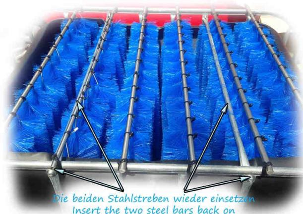
Wenn alle Bürsten im IBC Teichfilter eingehängt sind, müssen Sie die beiden Stahlstäbe wieder anschrauben. Diese hatten wir ja zum Aussägen der Deckel entfernt. Die Verstrebungen sind später mal ganz wichtig, wenn wir Wasser in den Tank füllen. Somit kann er sich nicht aufblähen.
