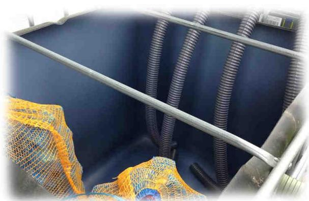
Sie sollten auch nun beide Behälter mit der Wasserwaage ausrichten. Sehr gut ist es wenn der obere Behälter leicht nach vorne zum Unteren läuft. Also mit leichtem Gefälle. Somit bekommt das Wasser Schwung. Nach hinten darf der Container nicht stehen. Sie sollten aber auch kein zu grosses Gefälle erzeugen, damit das Wasser nicht zu schief im IBC Container steht. Um die IBC Tanks für den Teichfilter auch ausrichten zu können, kann man Bleche oder Holzplatten unterlegen.
