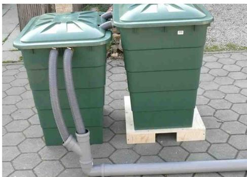
Die beiden Auslaufschläuche lassen sich optimal in einem Y-Stück des KG Rohres mit 75 mm Durchmesser bündeln. Hier sehen Sie auch wie bei 11 cm Höhe die beiden 50mm Anschlüsse über den Rand der unteren Tonne passen. Sauerstoff wird erzeugt und man spart sich 2 zusätzliche Anschlüsse am unteren Behälter.
