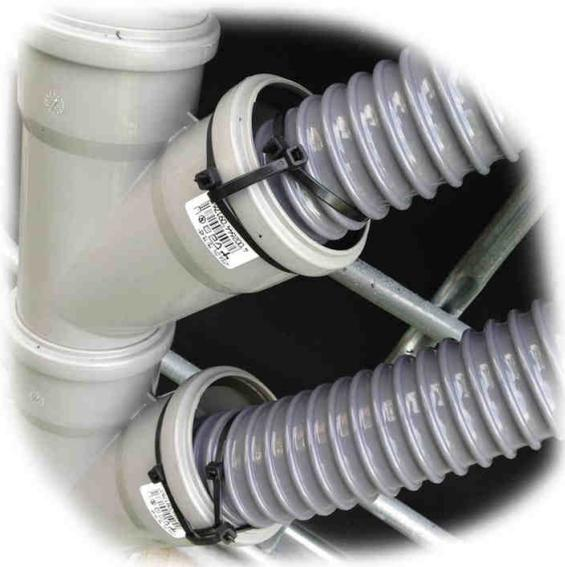
So kann man die Schläuche schnell und preisgünstig am KG Rohr befestigen. Legen Sie einen Kabelbinder um das KG Rohr, ziehen diesen aber noch nicht ganz fest. Dann legen Sie einen Kabelbinder um den Schlauch. Diesen ziehen Sie ebenfalls noch nicht ganz fest.
