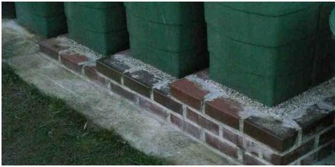
Man kann sich den Unterbau auch aus dekorativen Ziegelsteinen mauern. Dazu ist aber ein bisschen handwerkliches Geschick nötig. Achten Sie immer darauf dass der Unterbau eben und sauber ist. Nur so kann das Wasser in den Tonnen gerade stehen und Sie können dadurch möglichst viel Filtrervolumen ausnutzen, ohne dass Wasser an einer Ecke des Fasses überschwappen kann.
