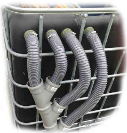
Sind alle 4 Schläuche montiert, sichern wir diese wieder mit den Spiralschlauchschellen. An den Y-Stücken sind die Schläuche noch nicht gesichert und unwissende Personen oder Kinder könnten diese herausziehen. Wir sichern die Schläuche nun mit Kabelbindern gegen Herausziehen.
