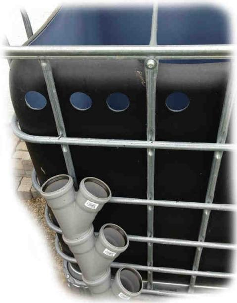
Die Vorbereitungen für den Teichfilter Rücklauf sind nun fast schon fertig. Achten Sie auf jeden Fall darauf, dass Sie diese Lösung mit den Y-Stücken auch so durchführen, um dieses Gebilde wie eine Sauerstoffpumpe zu nutzen. Wir haben diese Art des Rücklaufes absichtlich so erstellt.
