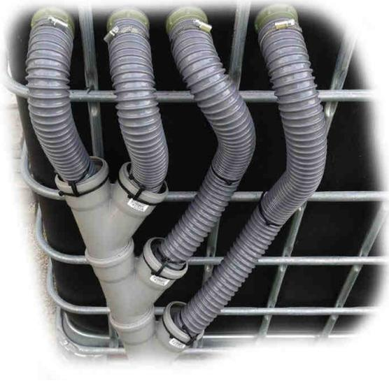
Auf diesem Foto sehen Sie, dass wir die beiden rechten Schläuche noch zusätzlich am Metallgitter des IBC Containers mit Kabelbindern gesichert haben. Somit liegen Sie dort schön sauber an. Insgesamt eine beeindruckende Anschlussmöglichkeit des Rücklaufs zum Teich.
