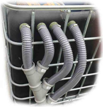
Sind alle 4 Schläuche montiert, sichern wir diese wieder mit den Spiralschlauchschellen. An den Y-Stücken sind die Schläuche noch nicht gesichert und unwisende Personen oder Kinder könnten diese herausziehen. Wir sichern die Schläuche nun mit Kabelbindern gegen Herausziehen.
