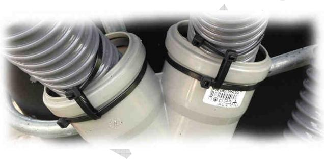
So können Sie ganz schnell, preisgünstig und effektiv die beiden Auslaufschläuche am 75 mm KG Rohr sichern. Das Foto braucht man hierbei nicht mehr extra zu erklären. Insgesamt brauchen Sie 6 Kabelbinder dazu. Dadurch wird verhindert, dass unbefugte Personen, auch wenn nur aus Versehen, die Schläuche aus dem Rohr ziehen können. Stellen Sie sich vor wie schnell es geht bis der Teich leer wäre.
