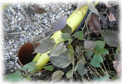
Durch das 110mm KG Rohr im Boden kann man den Schlauch und das Netzkabel der Pumpe unterirdisch zum Filter leiten. Wer sich einen grossen Vorteil verschaffen möchte, gräbt schon beim Bau des Teiches viele unterirdische Rohre mit ein. Sozusagen als Leerrohre. Später können Sie dabei auch Luftschläuche oder Stromkabel von Teichbeleuchtung und Sauerstoffpumpe unterirdisch verlegen. Durch kleine Pflanzen können Sie den Ein- und Ausgang der Rohre wunderbar verstecken.
