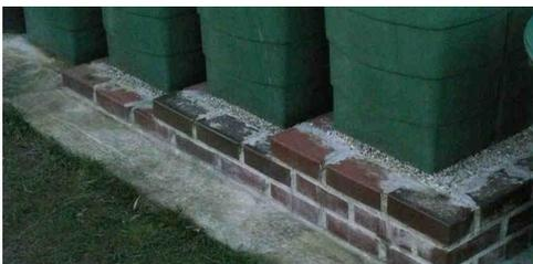
Man kann sich den Unterbau auch aus dekorativen Ziegelsteinen mauern. Dazu ist aber ein bisschen handwerkliches Geschick nötig. Achten Sie immer darauf dass der Unterbau eben und sauber ist. Nur so kann das Wasser in den Tonnen gerade stehen und Sie können dadurch möglichst viel Filtervolumen ausnutzen, ohne dass Wasser an einer Ecke des Fasses überschwapen kann.
