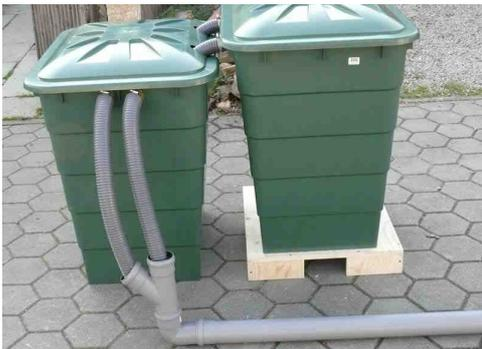
Die beiden Auslaufschläuche lassen sich optimal in einem Y-Stück des KG Rohres mit 75 mm Durchmesser bündeln. Hier sehen Sie auch wie bei 11 cm Höhe die beiden 50mm Anschlüsse über den Rand der unteren Tonne passen. Sauerstoff wird erzeugt und man spart sich 2 zusätzliche Anschlüsse am unteren Behälter.
